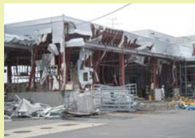
壊された建物
